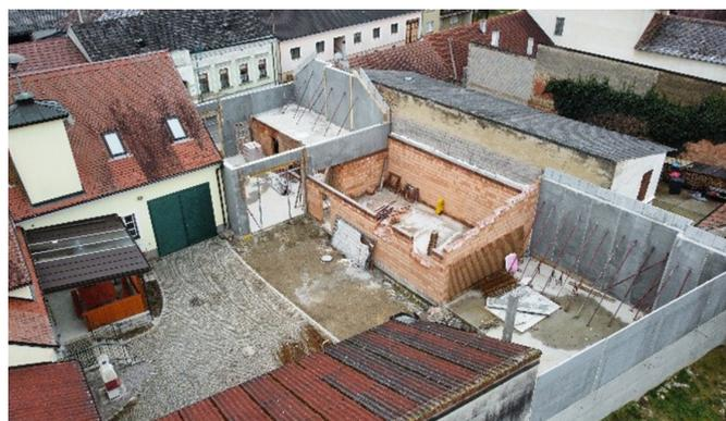
an die Firma Seyfried-Jecho aus Hollabrunn vergeben. In einer Woche wurde das komplette Grundgerüst des Dachstuhl aufgestellt und schon teilweise eingebrettelt. So dass in der gleichen Woche am Freitag, noch das Ausmauern der Giebelwände, durch uns in Angriff genommen wurden konnte.
